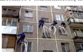
Герметизация швов
