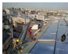
Гидроизоляция витражей
