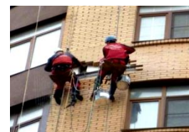
Восстановление кирпичной кладки
